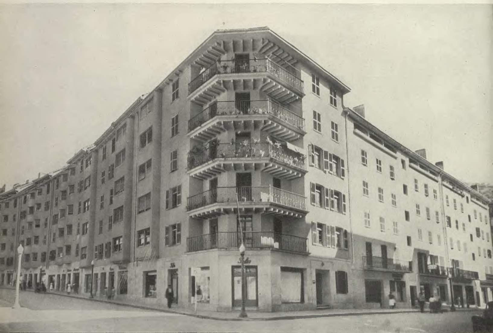
Vista de conjunto del Bloque de viviendas en la calle de María Angela.
