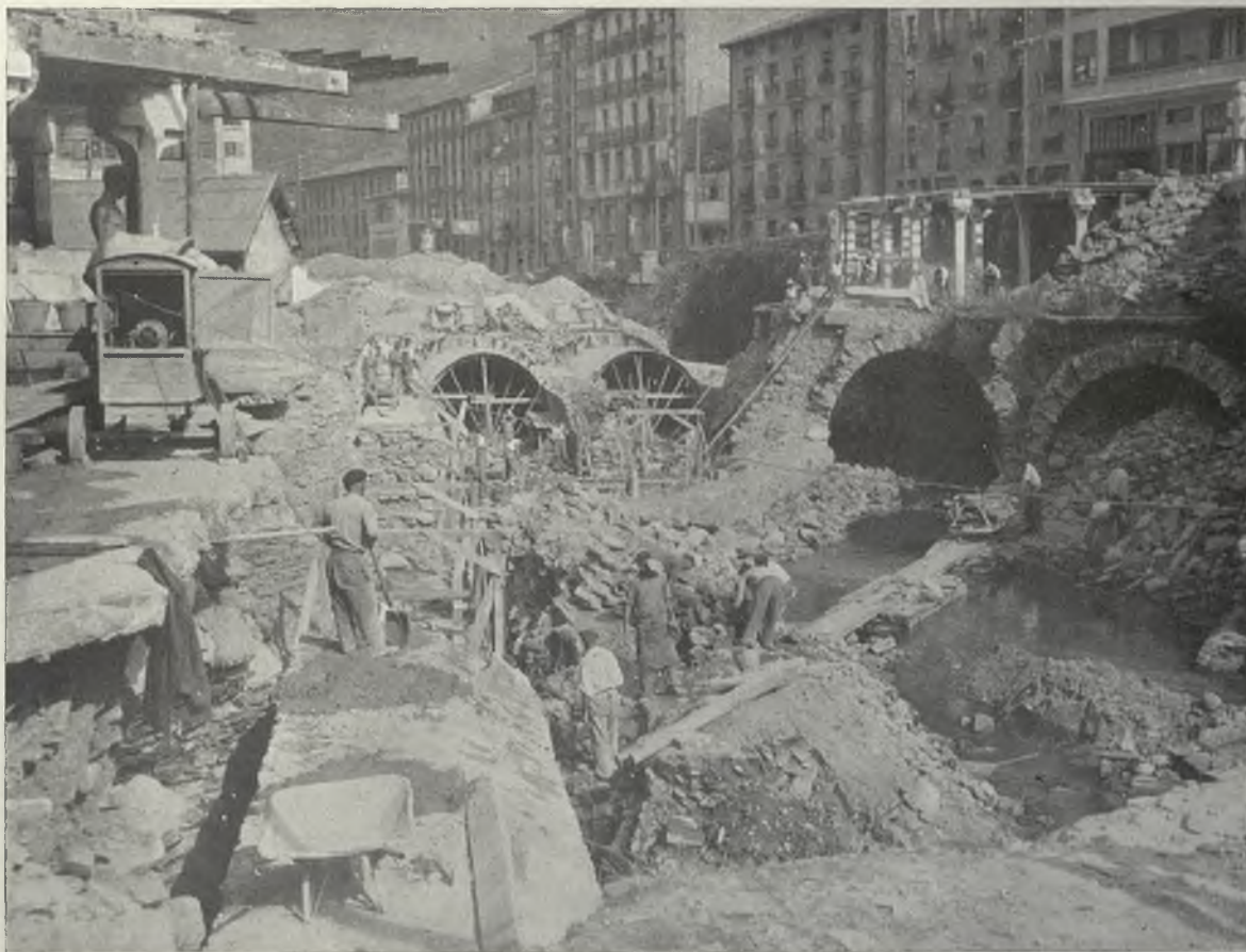
EIBAR.—Obras de cubrimiento del río Ego.
