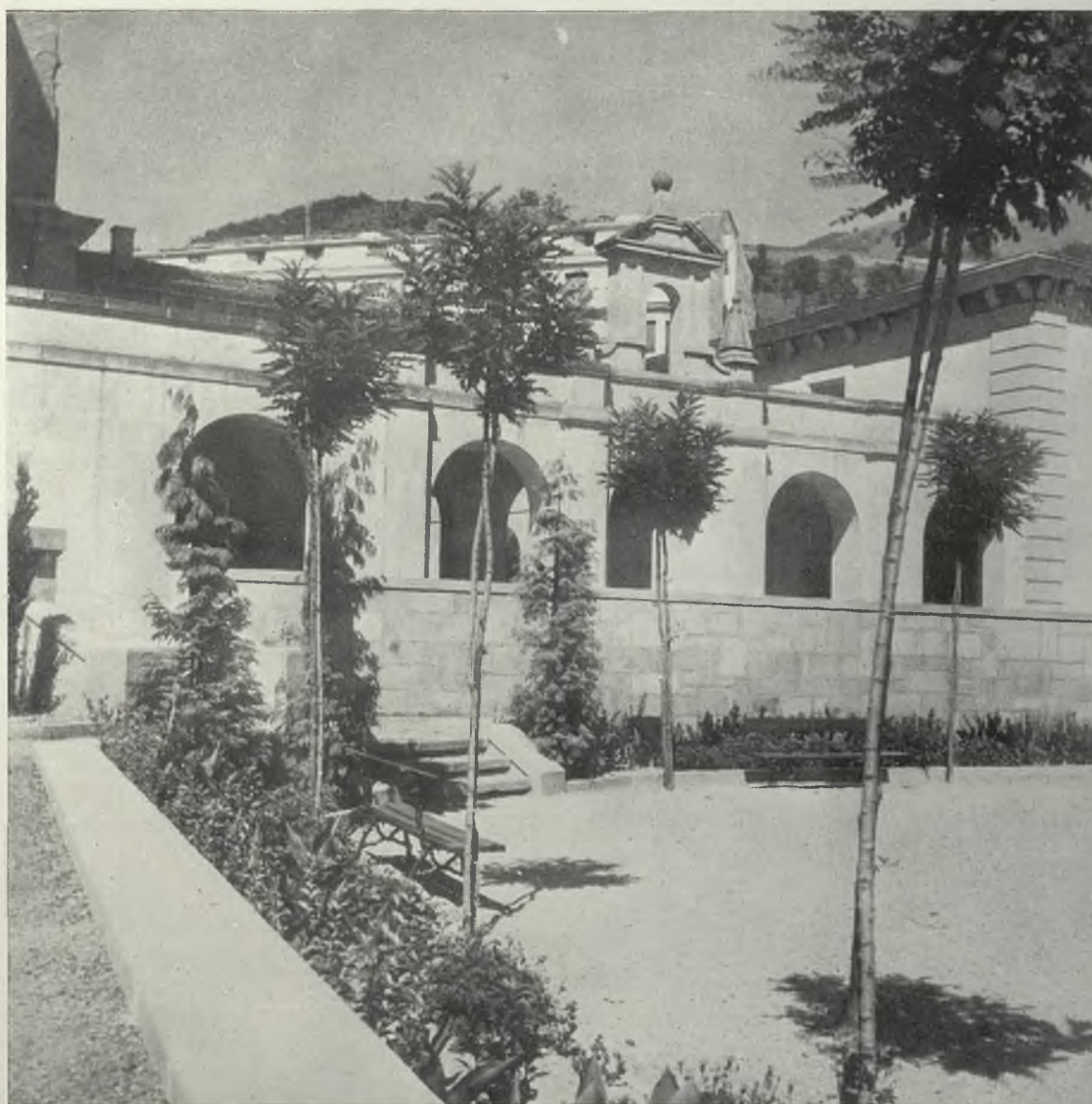
EIBAR.—Entrada al claustro de la Iglesia.
