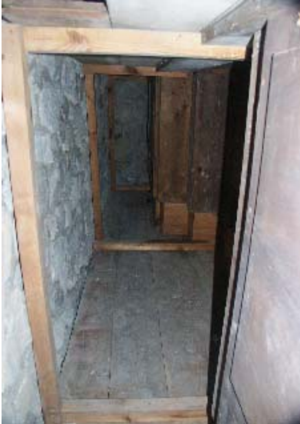
Sistema de anclaje al muro
