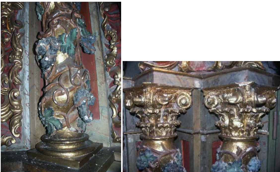
Pérdidas de policromía que dejan la preparación a la vista.
