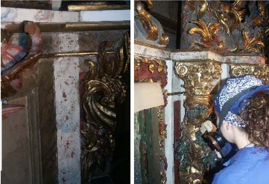
Eliminación de repintes. Bajo la policromía de la 2ª Intervención se aprecian restos ( rojo)de la policromía original
