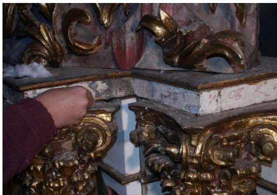
Tras la eliminación de repintes salen a la luz las piezas originales con su policromía y las piezas nuevas sobre las que se ha aplicado una base de color blanca.
