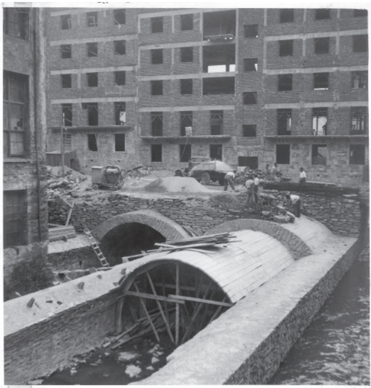
28. irudia. Ego ibaiaren estaltze- eta kanalizazio-lanak Maria Angela etxadiaren inguruan. Eibarko Udal Artxiboa. Hirigintza eta Obrak Argazki Funtza. Sig. 14.033. HIF.
