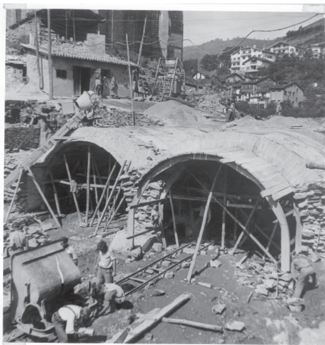
26. irudia. Ego ibaiaren estaltze- eta kanalizazio-lanak Eibarko Udal Artxiboa. Hirigintza eta Obrak Argazki Funtsa. Sig. 14.035. HIF.
