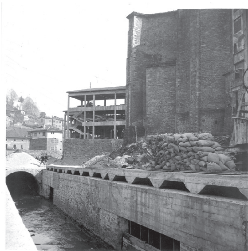
27. irudia. Ego ibaiaren estaltze- eta kanalizazio-lanak San Andres parrokiaren inguruan. Eibarko Udal Artxiboa. Hirigintza eta Obrak Argazki Funtza. Sig. 13.041. HIF.
