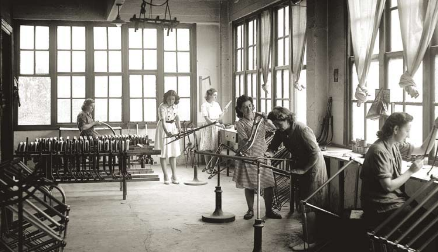
Interior de la fábrica Norma, las fileteadoras se aplican en el acabado, pintura y adhesivos de los cuadros y horquillas de bicicleta, 1948. AME/EUA. Fondo Castrillo-Ortuoste.
