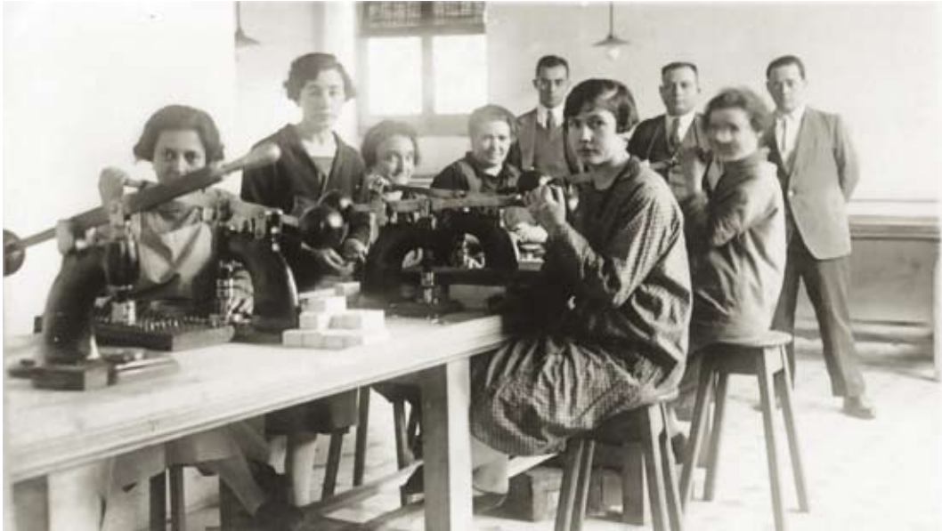
Mujeres trabajando en el Banco de Pruebas hacia 1927, (Angelita Lizarralde, segunda por la izquierda). Uno de los cometidos que las mujeres desempeñaban habitualmente en el Banco de Pruebas era la recarga manual de los cartuchos. La vaina se rellenaba de pólvora, tapándola posteriormente con fieltro o un taco de cartón, después se introducían perdigones de plomo y se cerraba con otro taco de cartón. Foto Ojanguren. Colección Arrate Otaleku. Foto cedida para la exposición "Eibarko Emakumeak 1900-1950" organizada por el Ayuntamiento de Eibar en marzo de 1996.
