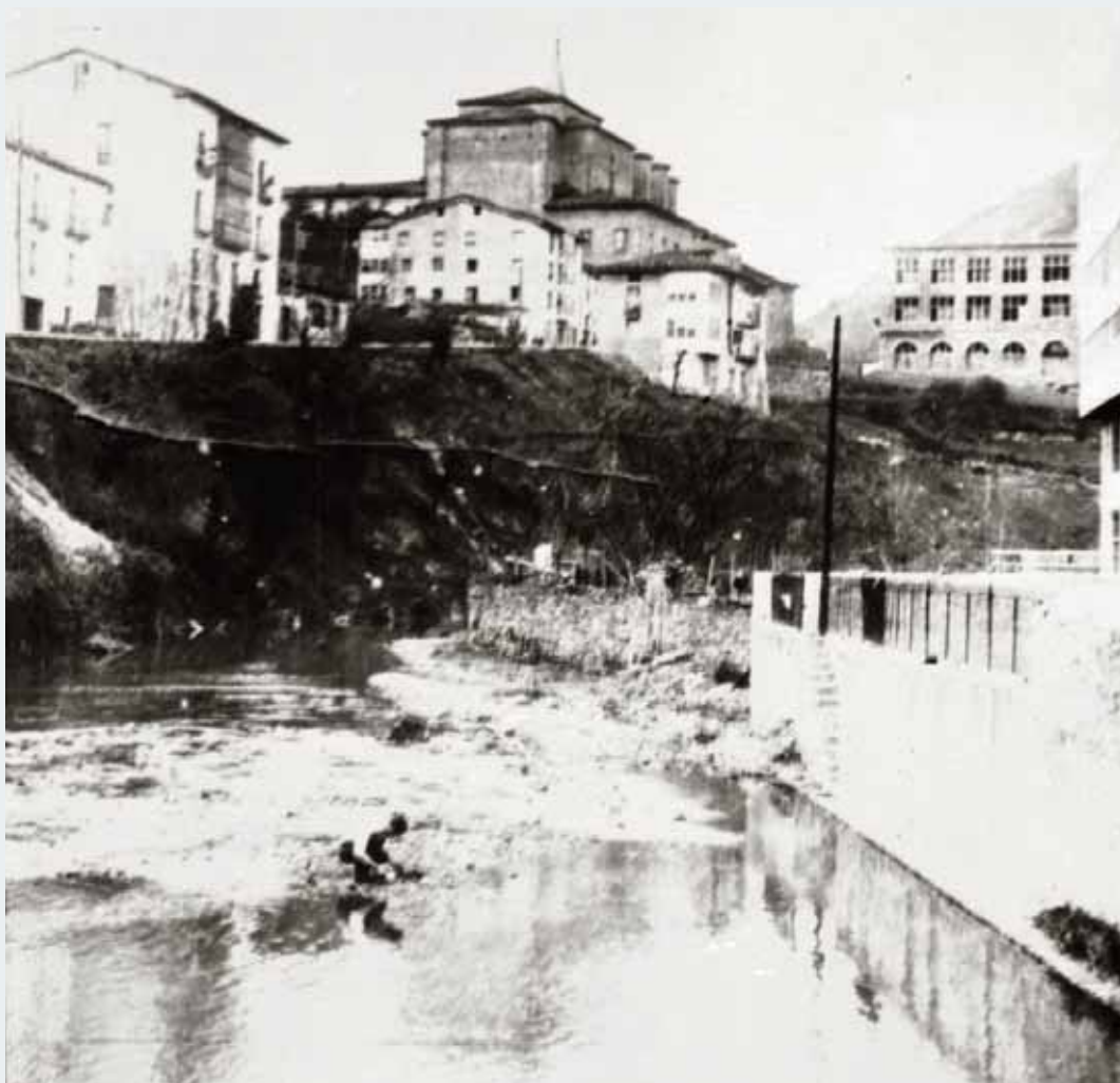
Foto antigua (1913) en la que divisa la parte superior del convento de Isasi y la Escuela de Armería.
