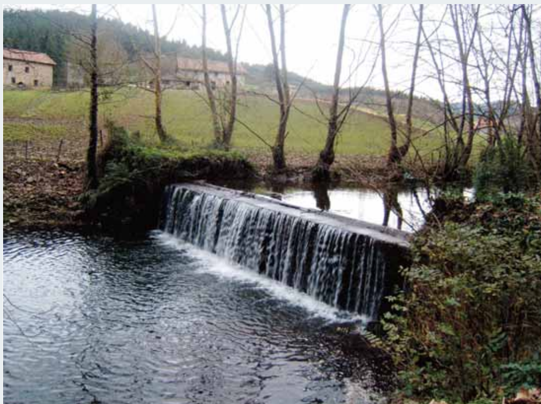
Presa “presia” de molino construida en piedra de sillería para elevar el nivel de agua del río y desviarla hasta el depósito del molino “aldaparoa”. Foto: Koldo Lizarralde.
