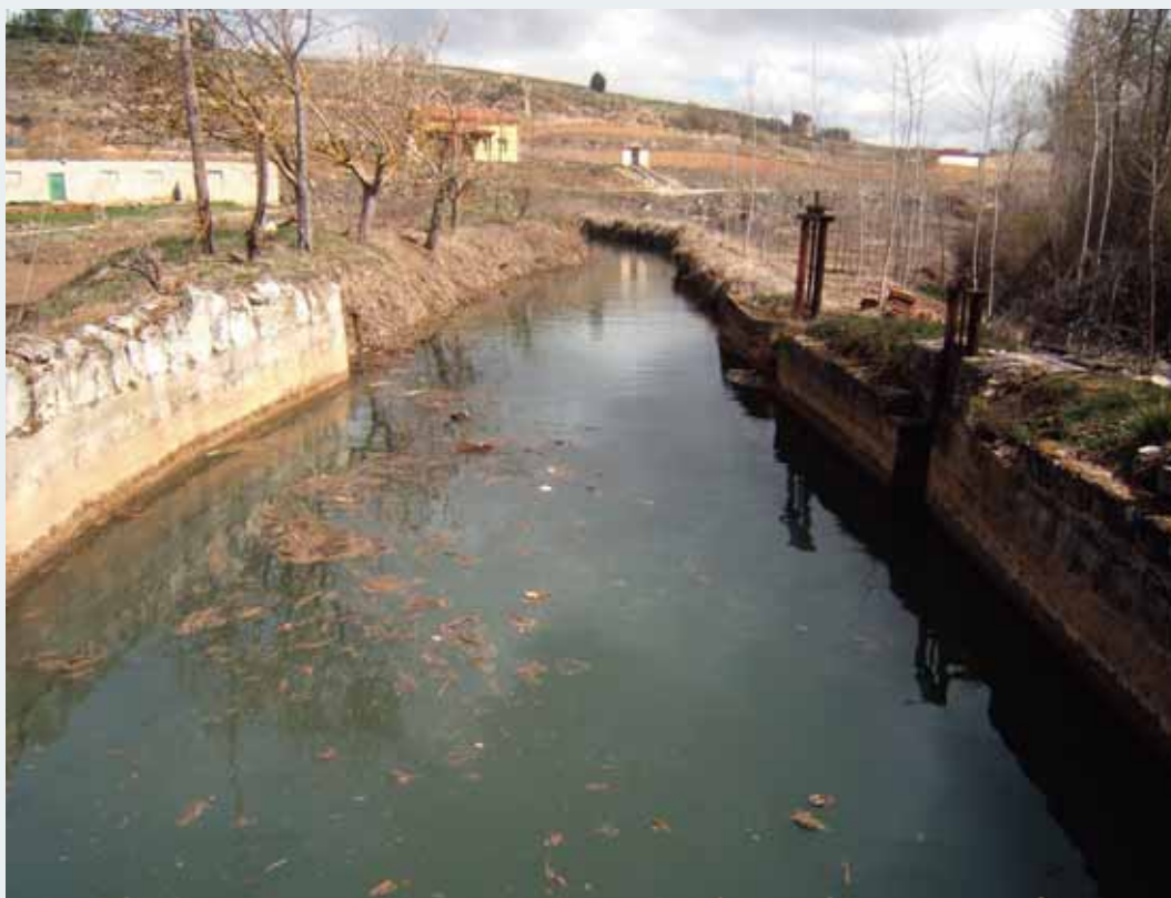
Canal “kanala” por donde discurre el agua desviada de la presa que llega hasta el depósito del molino. Foto: Koldo Lizarralde.
