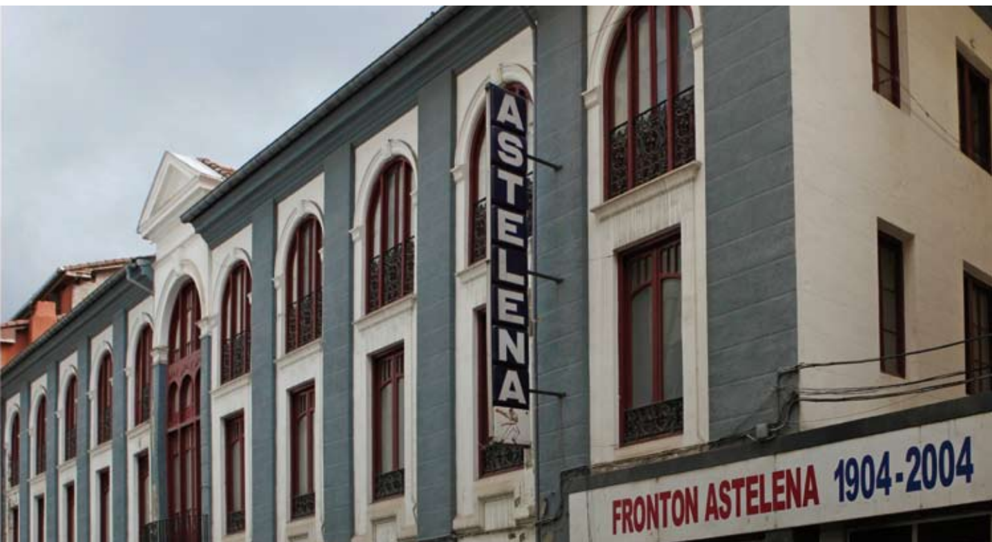
Frontón Astelena de Eibar. Vista de la fachada.
