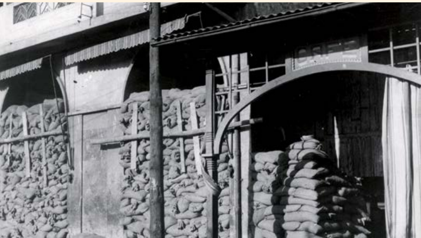
1936-1937. Refugio antiaéreo en los bajos del Tupi.
