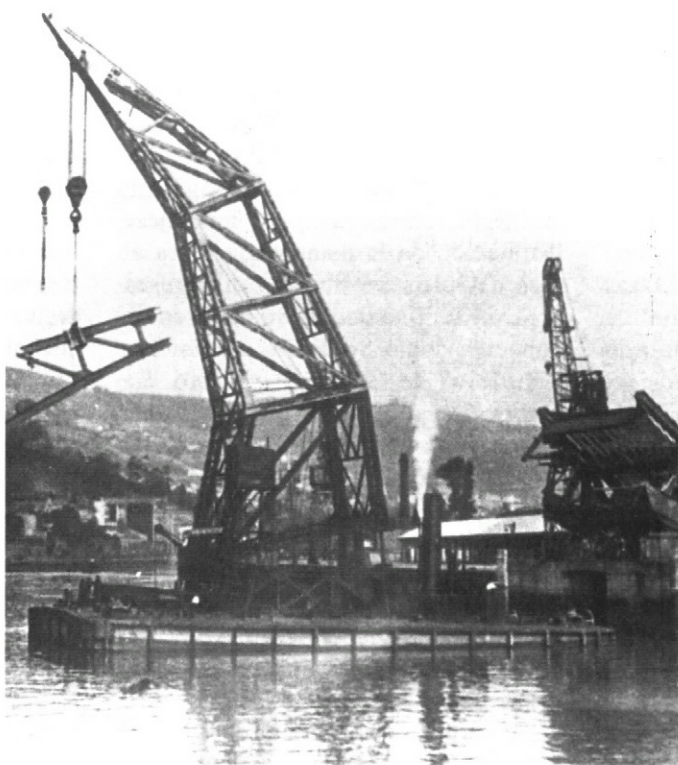
En octubre de 1936 comenzaron a producir las "Industrias de Guerra Guipuzcoanas" en Deusto. El 31 de marzo de 1937 finalizaron las obras de construcción del puente de Deusto, tras su comienzo en 1932.
