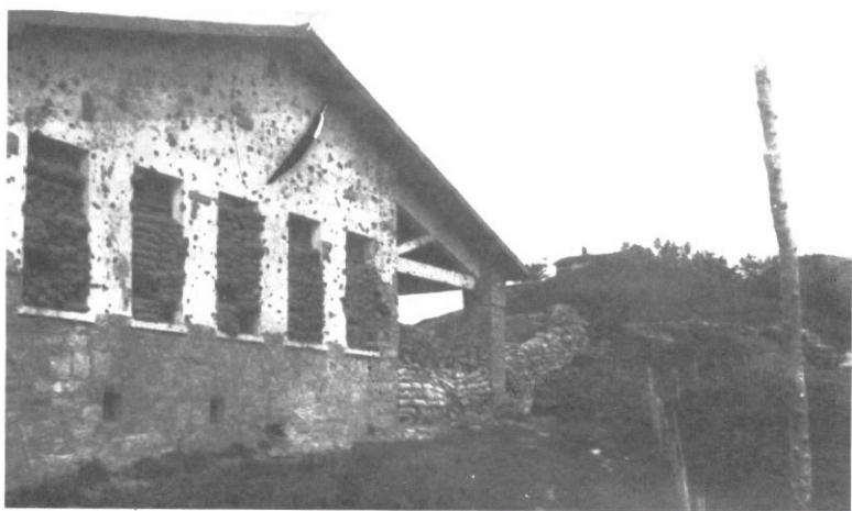
Vista de la loma de Santa Cruz; en primer término, el conjunto fortificado de la escuela y la ermita al fondo. La fachada de la escuela es una muestra del gran número de impactos que afectaron a la misma. Ojanguren.
