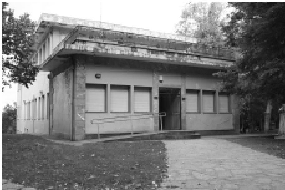
Las obras van a tratar de resolver las deficiencias detectadas en el inmueble.
