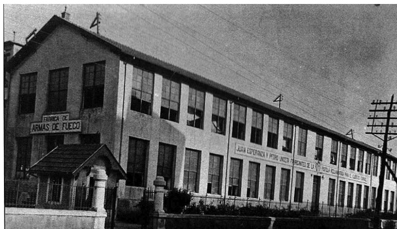
Pabellón de la fábrica, obra del contratista Juan Maguregui “Txikerra” .
