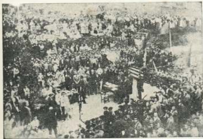
Colocación de la primera piedra del Ayuntamiento Año 1889
