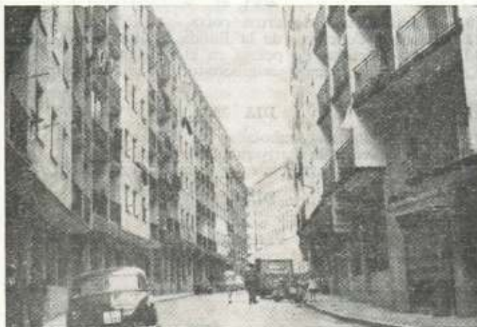
Urki bajo, urbanizado y con muro de contención.
