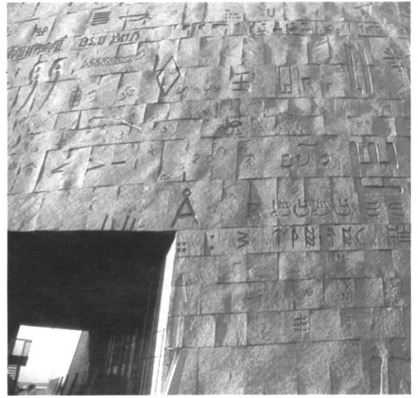
Vista del muro exterior, construido con granito de Assuán, en el que se han inscrito 4.000 caracteres en lenguas de todo el mundo.
