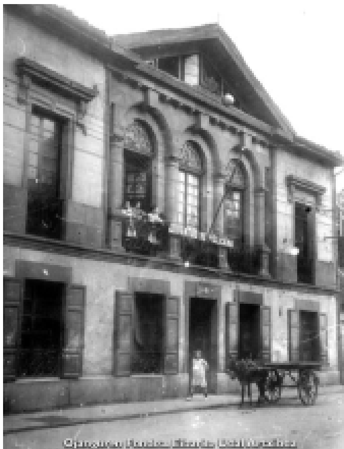
Fachada principal del Salón Teatro a la calle Fermín Calbetón en los años 1930.
