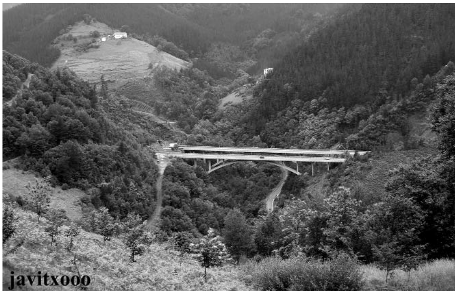
Viaducto AP-1 Sagar-erreka.
