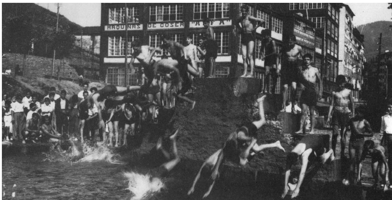
En 1936 disponíamos en Eibar de una piscina al aire libre, construida en Kakalardokua. Se clausuró por los vertidos tóxicos.
