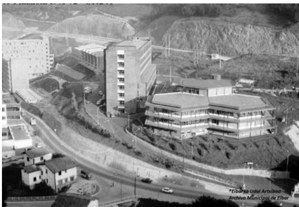
Vista general. El edificio del Colegio Jaizkibel todavía sin construir.
