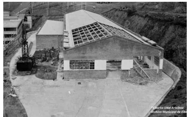
Obras de ampliación del edificio denominado Polideportivo.
