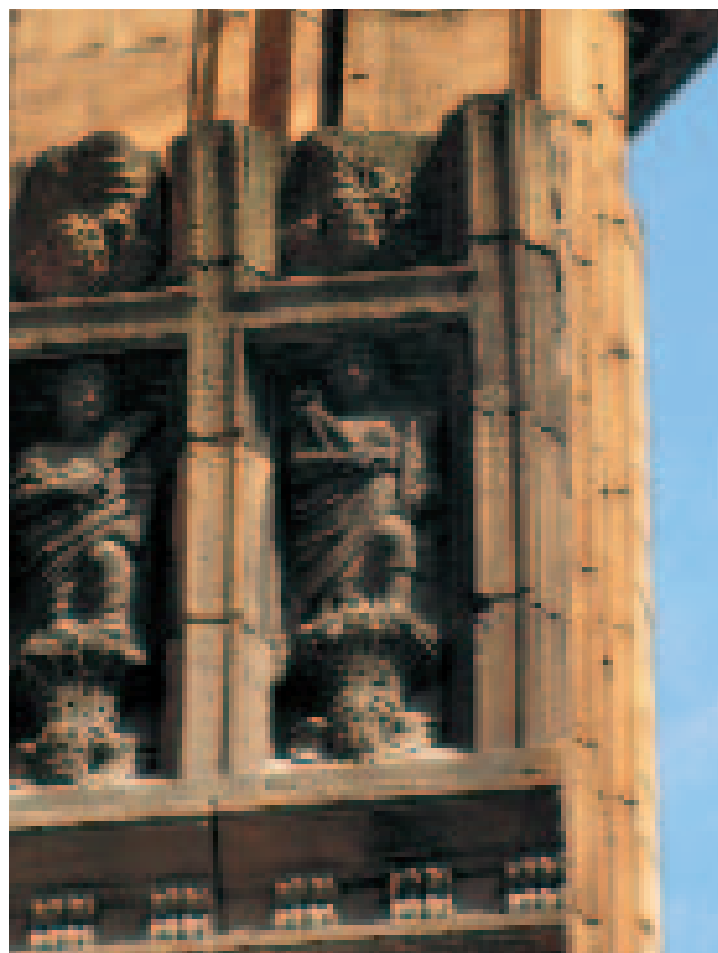
Resto de la antigua cornisa, fachada Sur. Imágenes de dos santas talladas en piedra. Foto: Satur Peña.
