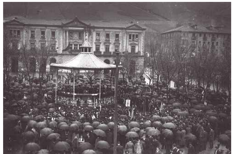
Musika-kioskoa (1902) eta udaletxea, jatorrizko teilatuan frontoiak eta akroterak dituela.
