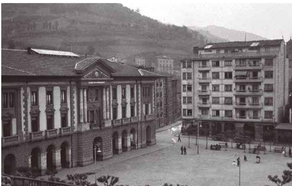
Udaletxea eta Manuel Cortaberriaren etxea, Urbano Manchobas Careaga arkitektoarena (1887-1968), 1931n eraikia.
