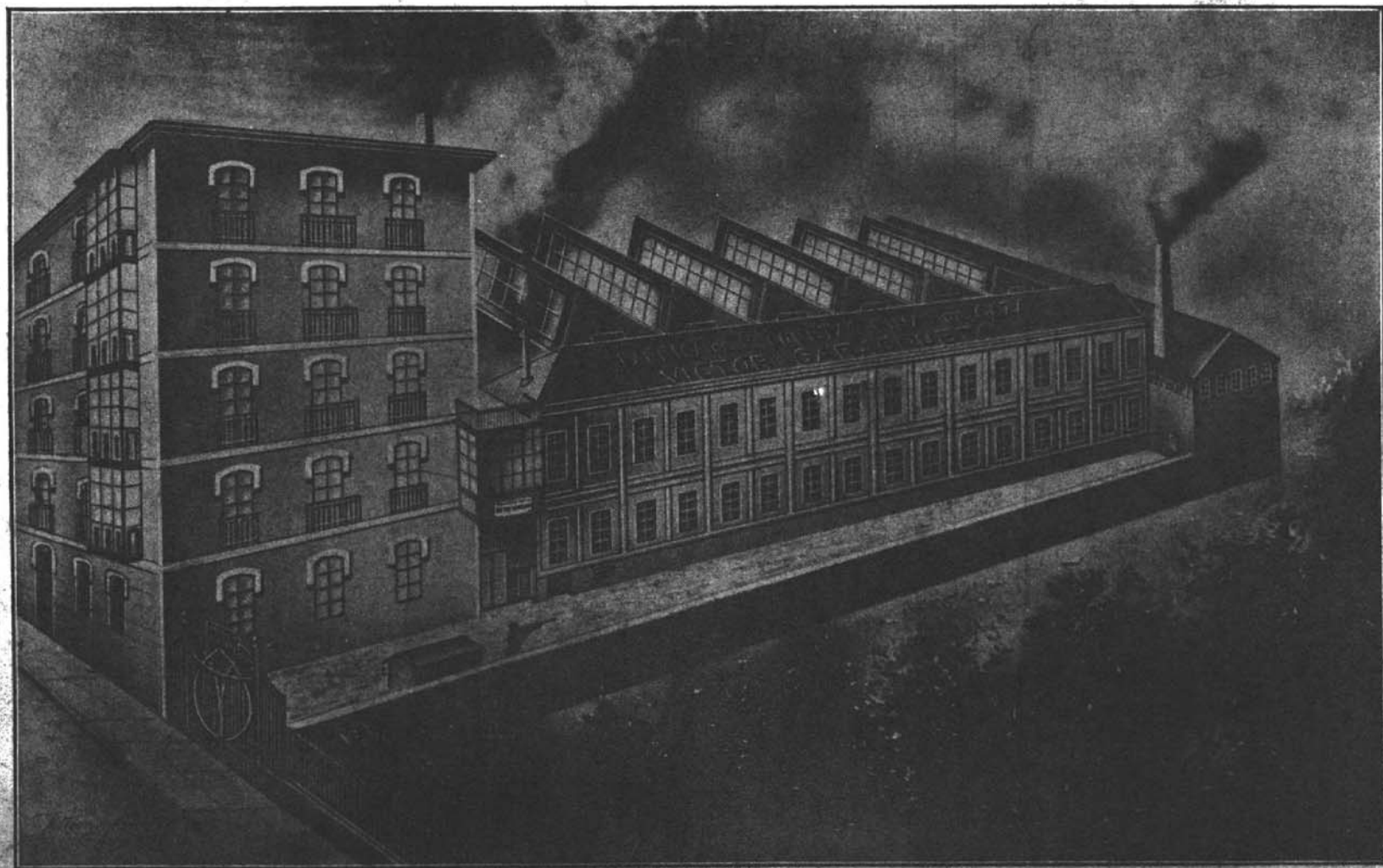
Vista exterior de la fábrica
