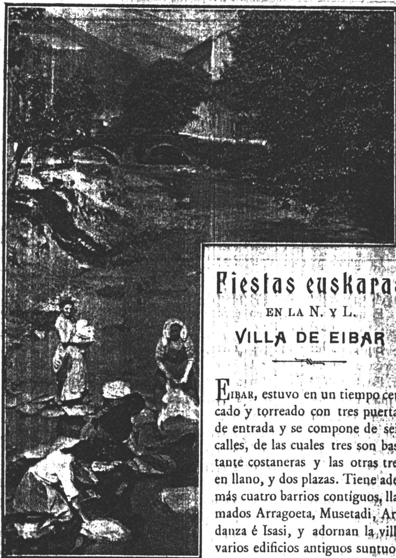
Puente de Uscusua EIBAR
