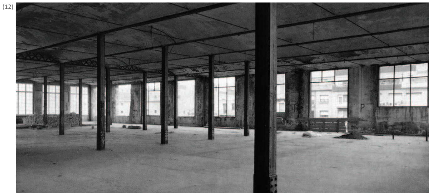
(11) Imagen de la prueba de carga realizada sobre un tramo de forjado en Ca l'Aranyó. Imagen cedida por A.Vilanova.
