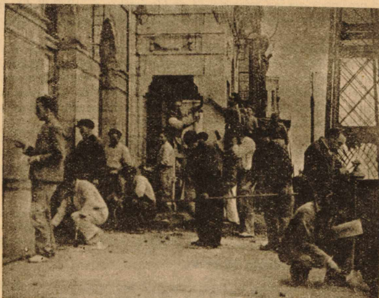
Los reclusos trabajando en la reconstrucción de Portugaete
