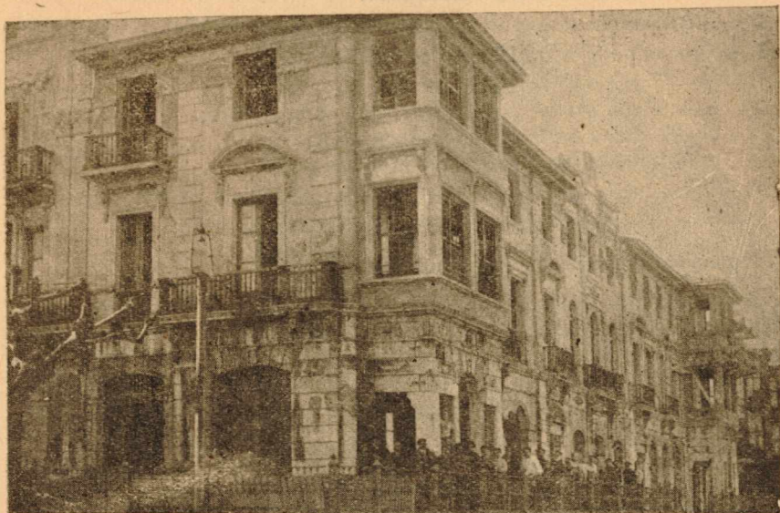
Casa reconstruída por los reclusos en Portugalete
